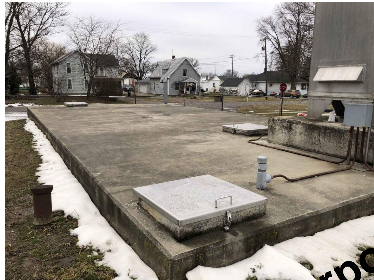
EXISTING DETENTION TANK SCALE: NONE
