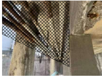
CONDUIT DEMO DETAIL PICTURE 1
